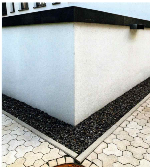
Fertige Gebäudeecke mit Kiesstreifen Foto und Zeichnungen: Dörken
